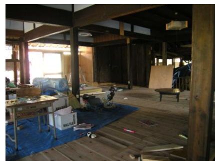
上；台所・食堂天井・梁が古民家の味。 下；各室、床壁が出来た。
